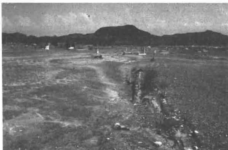
Foto 4 : Sector centro y sur de Armero afectado por flujos menos densos y más rápidos que el que se proyectó sobre la parte norte de la ciudad. Las construcciones han sido arrancadas a nivel de los cimientos.
