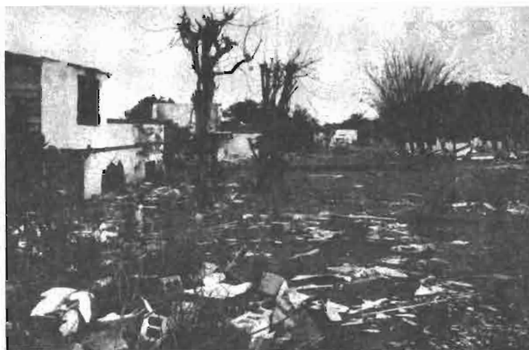
Foto 3 : Sector norte de Armero afectado por un flujo muy denso y relativamente lento. Las destrucciones son parciales.
